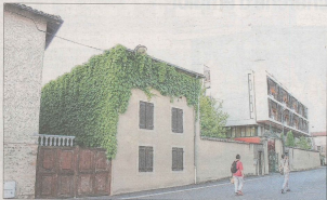
■ Comme le bâtiment se construit dans le périmètre de l'Hôtel-Dieu, classé monument historique, les architectes ont prévu une passerelle vitrée permettra de conserver une percée visuelle. Photo Marie-Pierre JANDEAU
